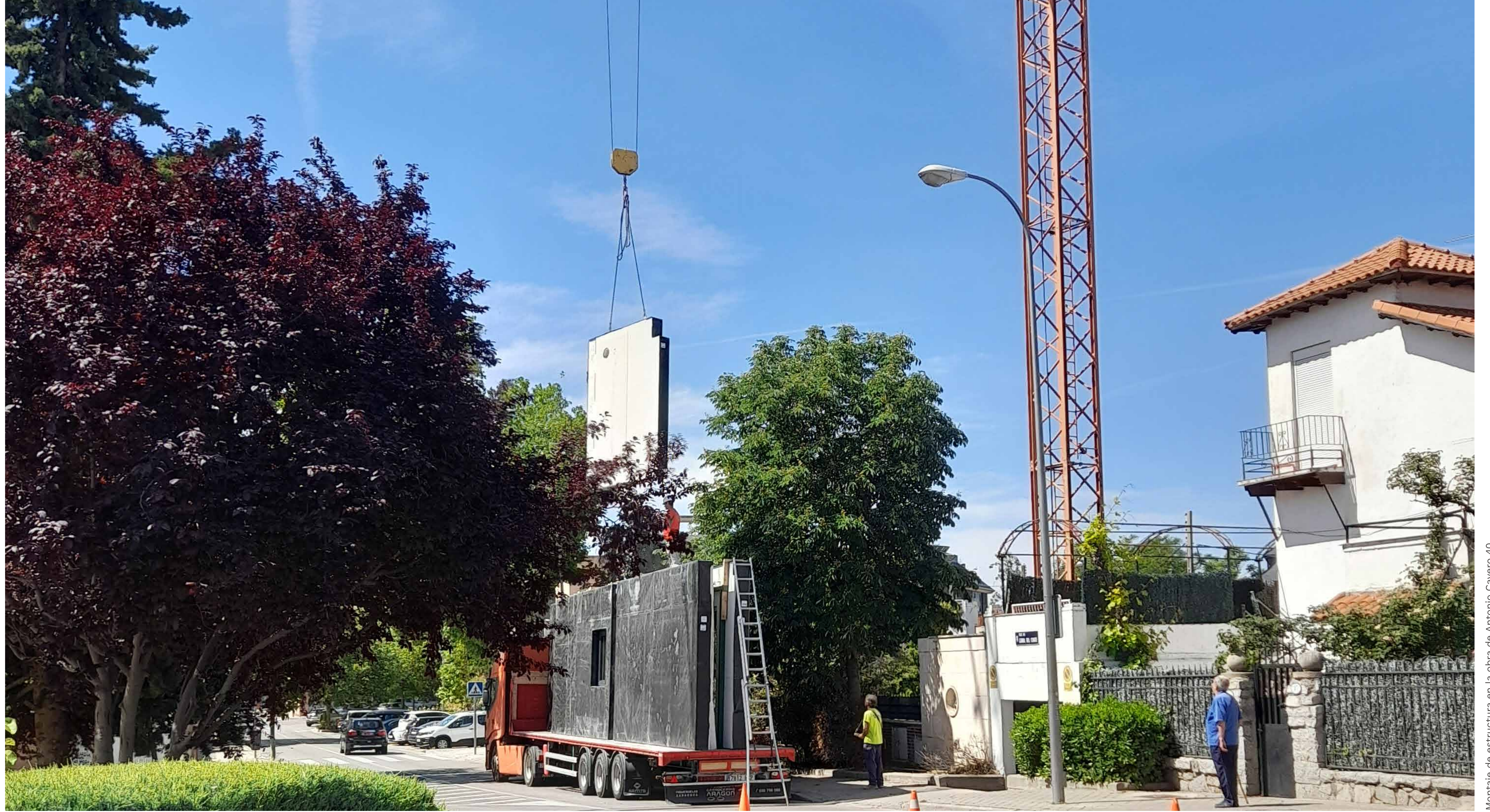
Montaje de estructura en la obra de Antonio Cavero 40
